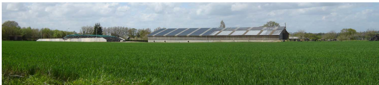
Le bâtiment agricole et le silo ci-dessus n'ont pas fait l'objet d'un accompagnement végétal ; ils ont un impact fort sur le paysage, d'autant plus important dans ce paysage plat et ouvert.
