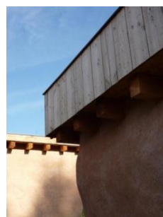
Gîte rural et chambres d'hôtes / extension en bottes de pailles – enduit chaux/sable Savigné-sous-le-Lude
