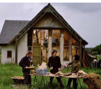
Auto-construction en paille Saint-Germain-d'Arcé
