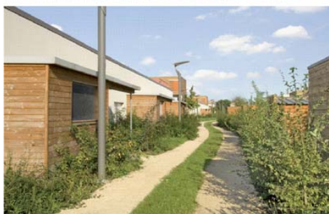
Châlons-sur-Saône (71) - ZAC Saint-Jean-des-Jardins opération expérimentale de 30 logements individuels groupés et 16 logements en accession à la propriété
